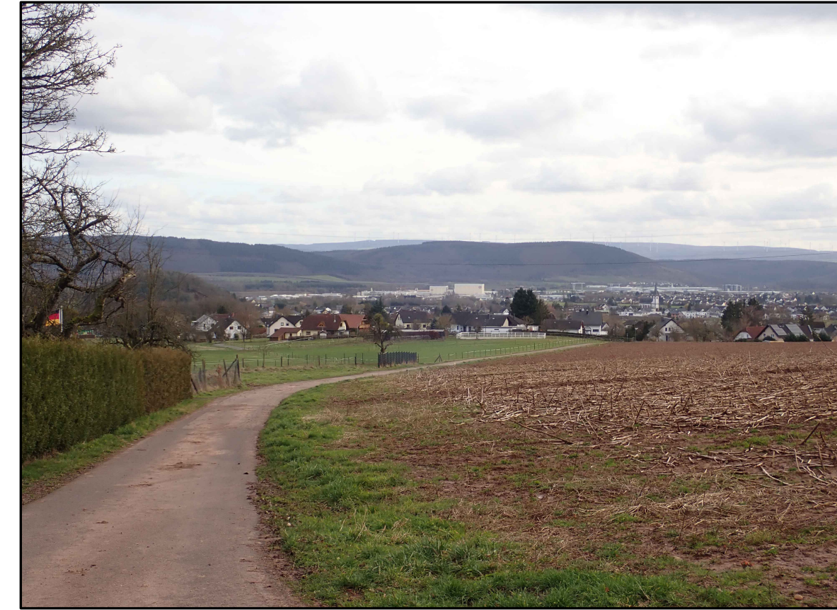
8 ehem. Tretbecken Wittlich-Dorf
