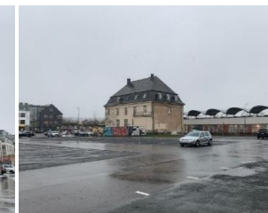
Blick von Norden
