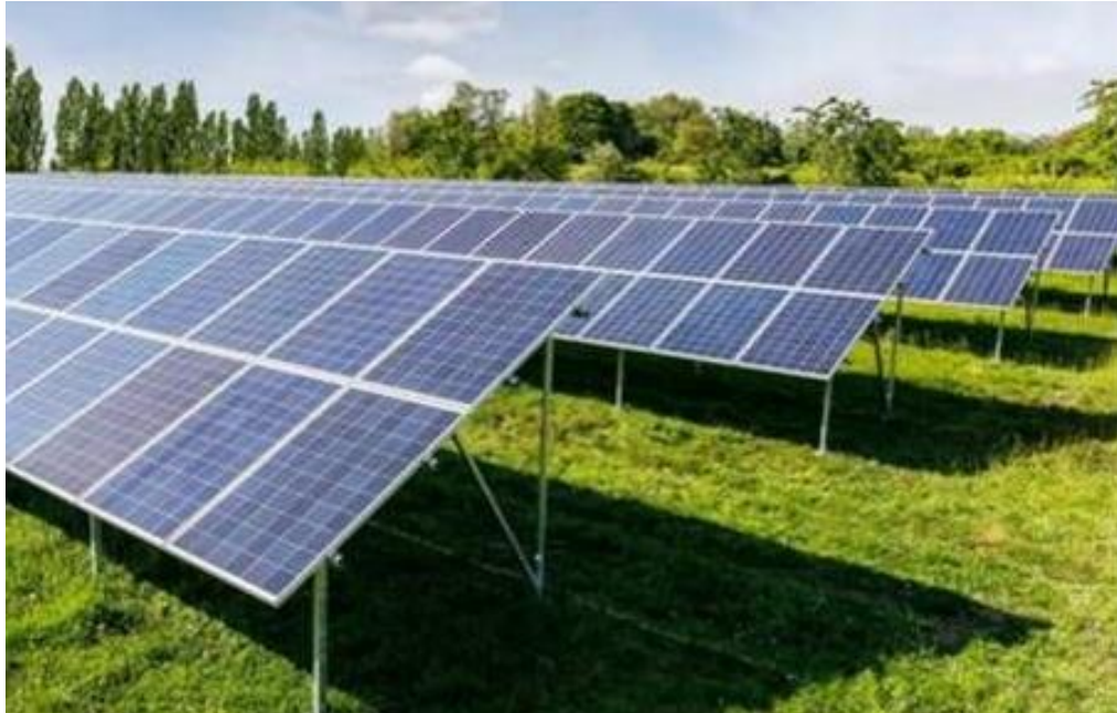
Abbildung 6: Beispiel der Montage der Solaranlage.
