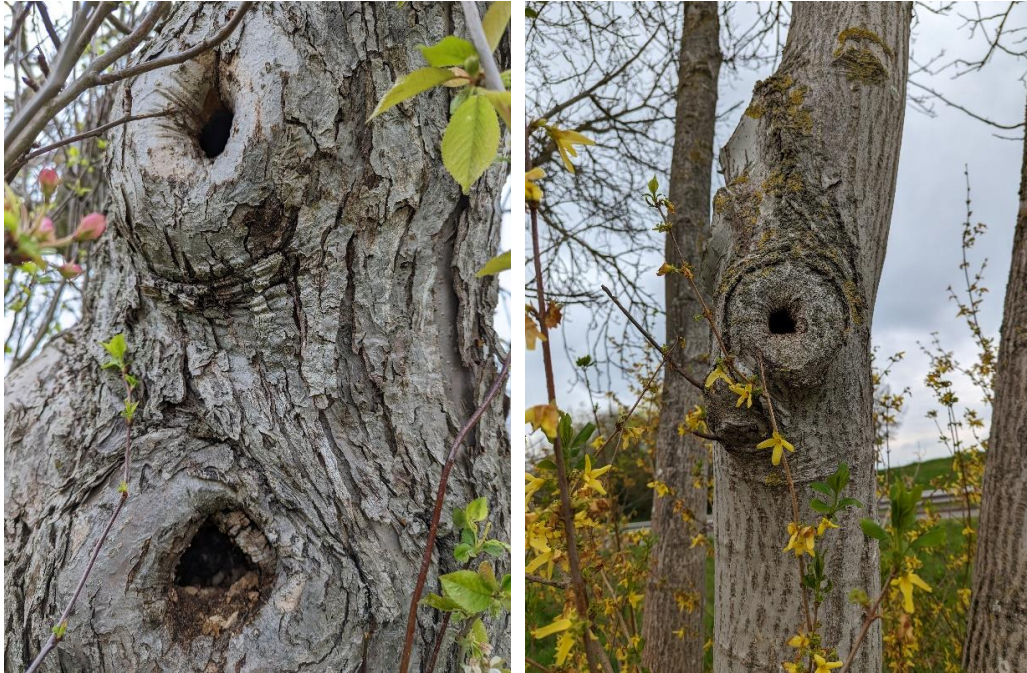
Abbildung 13: Faunistisch relevante Strukturen, insbesondere Baumhöhlen innerhalb der Baumreihe des Eingriffsbereichs.
