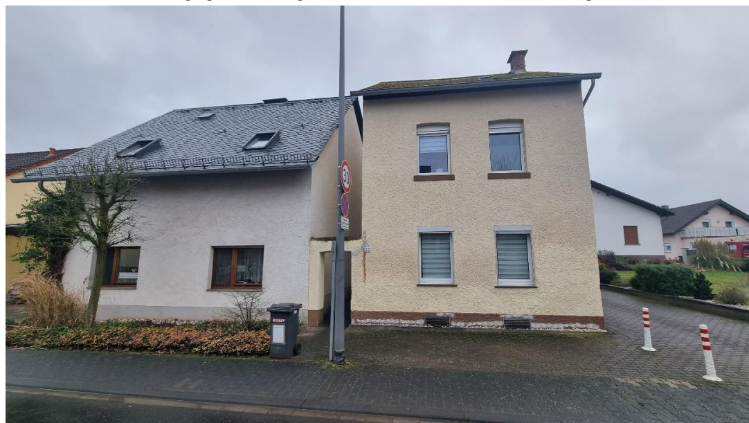
Bild 5, Gebäude auf gegenüberliegender Straßenseite, 1 und 2 Vollgeschosse
