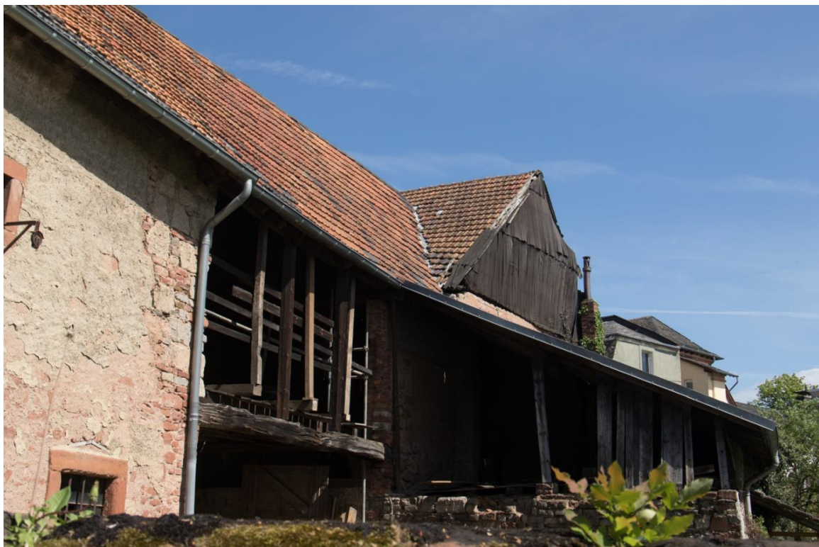
Foto 2: Südseite der Scheune (24.04.2019).
