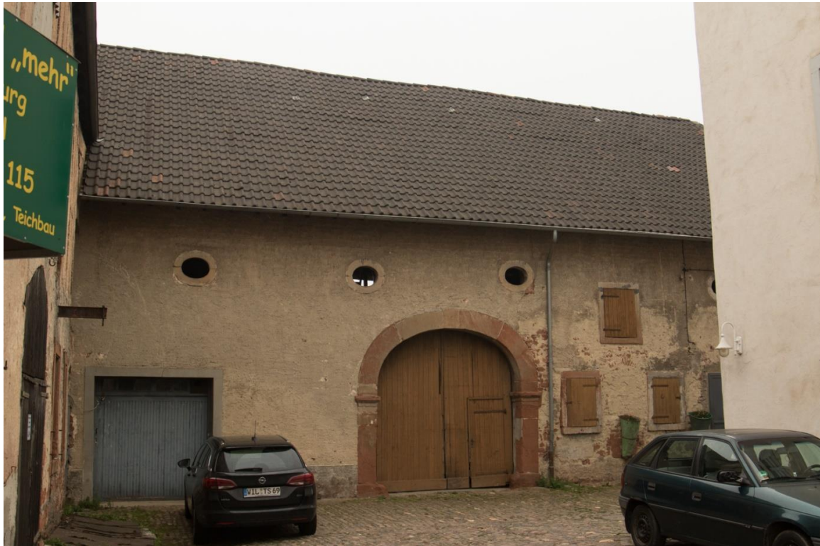
Foto 1: Nordseite der Scheune (08.04.2019).
