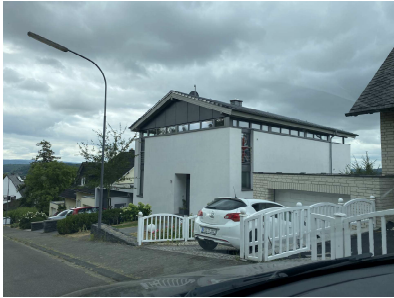
Alte Chaussee Nr. 5 3 Vollgeschosse (EG+OG+UG) Dachneigung 16°
