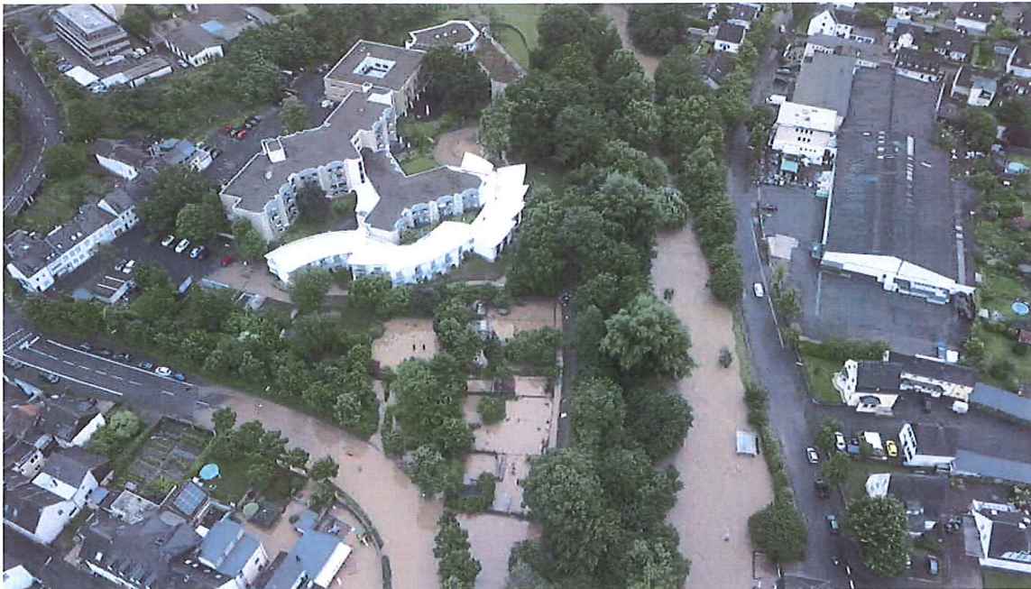
Luftbild vom Hochwasserereignis 14./15. Juli 2021, Planungsbereich
