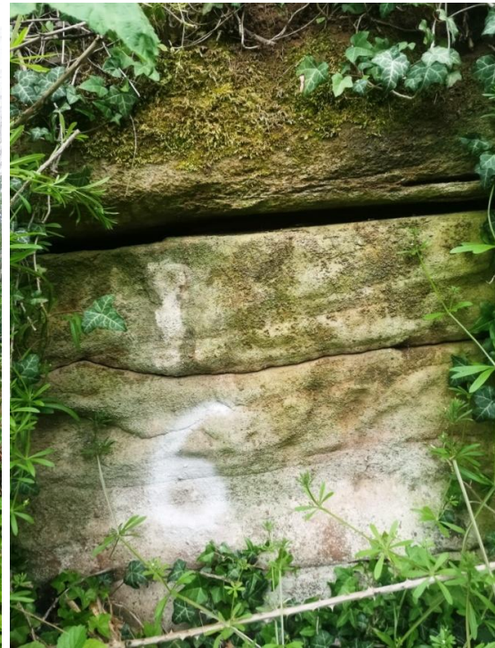
Nahaufnahme der Felsspalte in Areal 6
