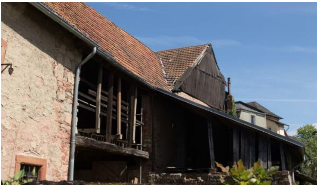
Abb. 25: alte „Scheune“ (Quelle: Artenschutzrechtliche Vorprüfung)
