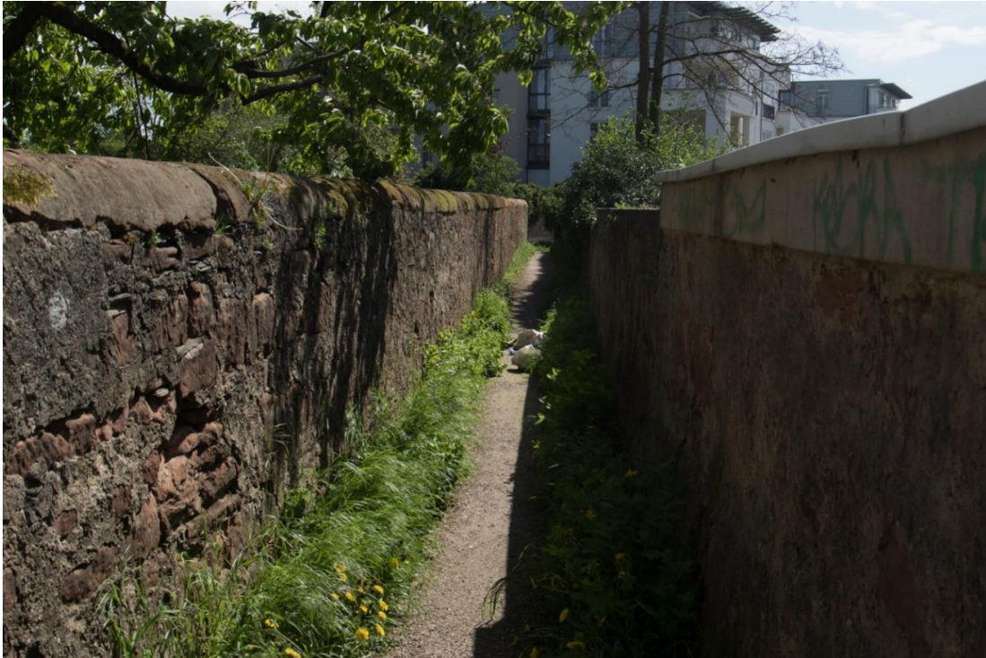
Foto 7: Bruchsteinmauer entlang der Parfümgasse (24.04.2019).
