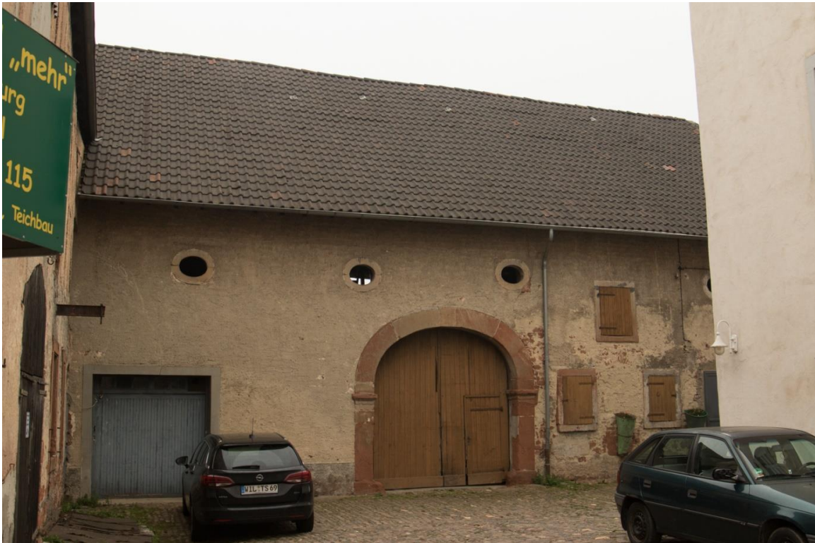
Foto 1: Nordseite der Scheune (08.04.2019).
