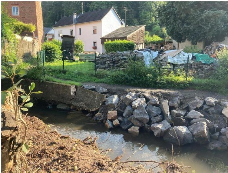
*Bild 73 – Abgegangene Betonmauer (gesichert)*
