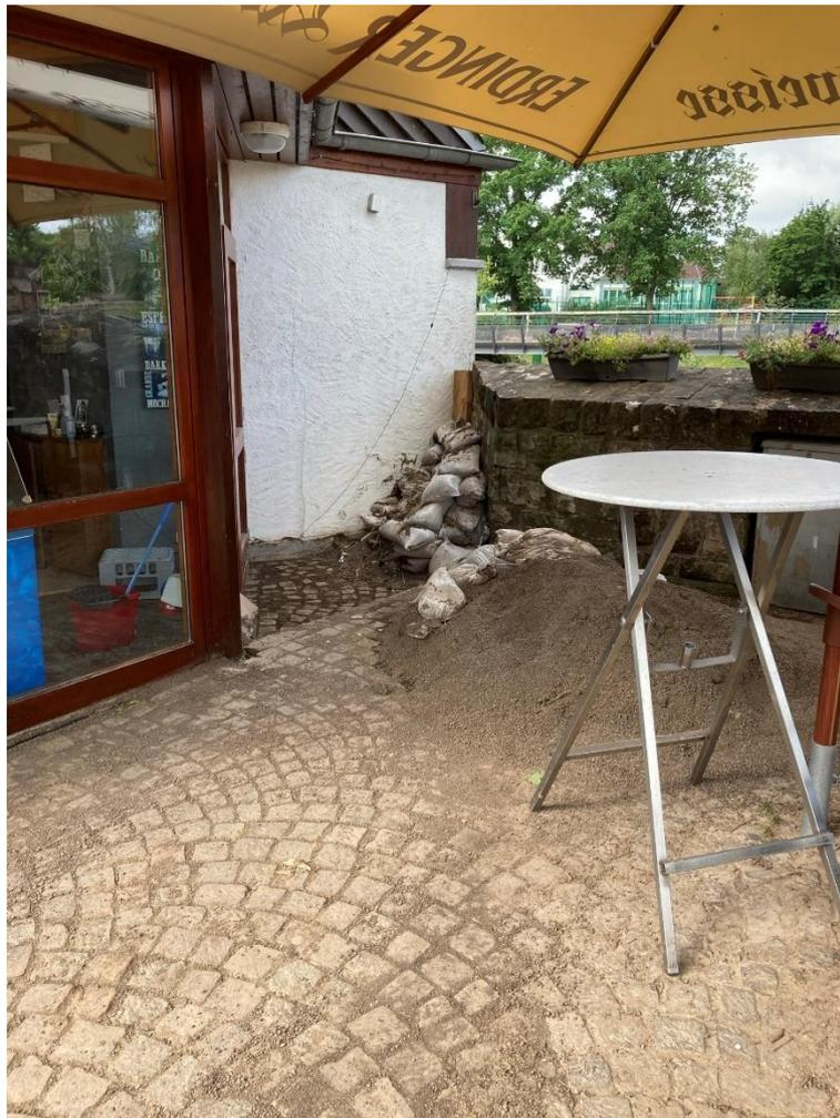
*Bild 29 – Pavillon rechts provisorische Sicherung mit Sandsäcken*
