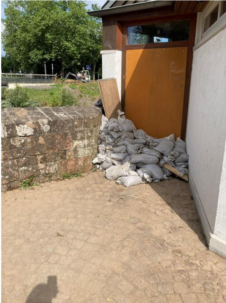
*Bild 28 – Pavillon links provisorische Sicherung mit Sandsäcken*
