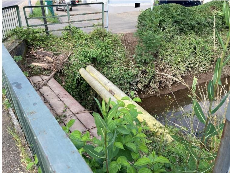
*Bild 4 – Versorgungsleitungen Brücke Mühlgraben gegen Fließr.*
