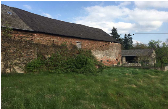
Abbruch der Scheune bis zum Denkmal Übernahme der langen Gebäudeform
