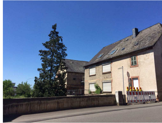
Abbruch des bestehenden Hauses Rückbau von der Strasse
