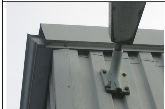
An der südlichen Halle ist an der westlichen Seite der Maueraufbau nicht vollständig mit Blech verkleidet und weist offene Bereiche bei den Rohren und Leitungen auf. Ebenfalls besitzen die Mauerübergänge viele Ritzen und Spalten und das Dämmmaterial ist stellenweise sichtbar.
