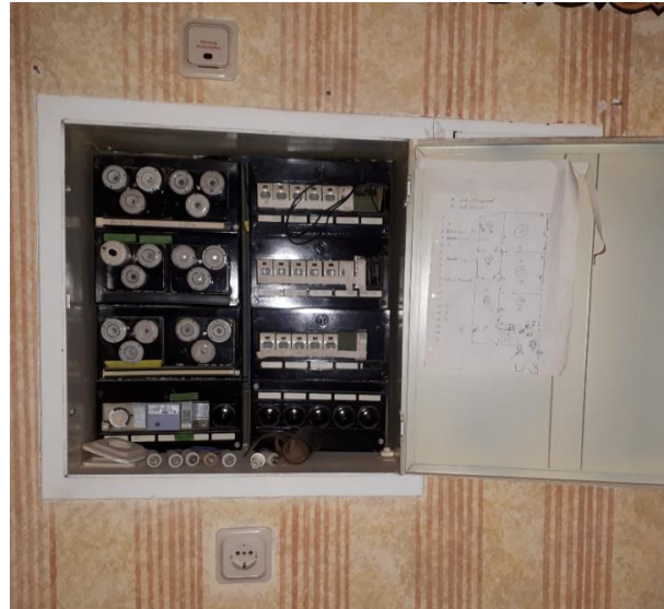
Abbildung 9: Abgängige Unterverteilung
