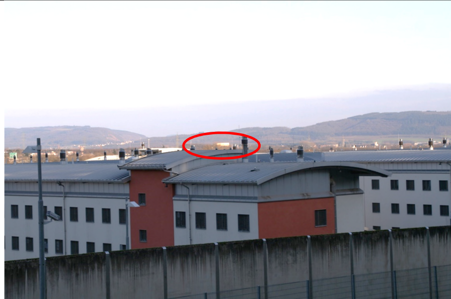
Foto 28: Standort 12 - Fallerkapelle Wittlich / Waldrand
