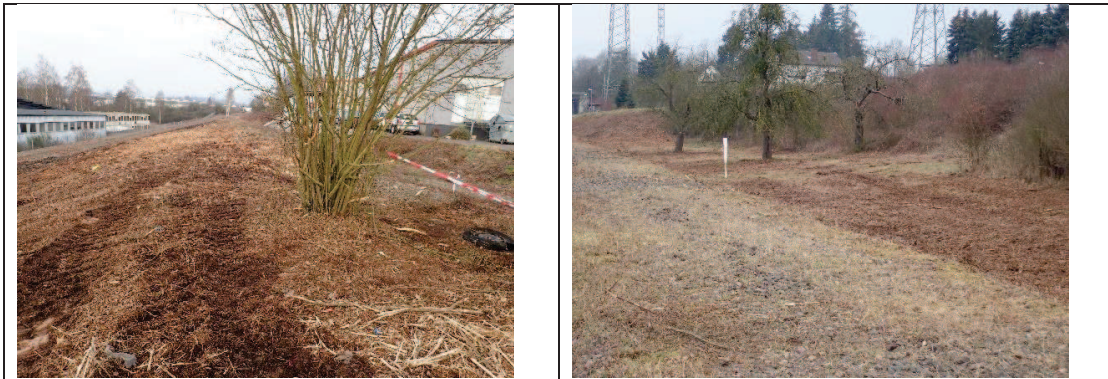
Die Trasse wurde vor Beginn der Vegetationsperiode gemulcht und von Gehölzbewuchs freigestellt, wobei Einzelbäume und Sträucher erhalten wurden. Bild links: nordwestlicher, Bild rechts: südöstlicher Abschnitt.
