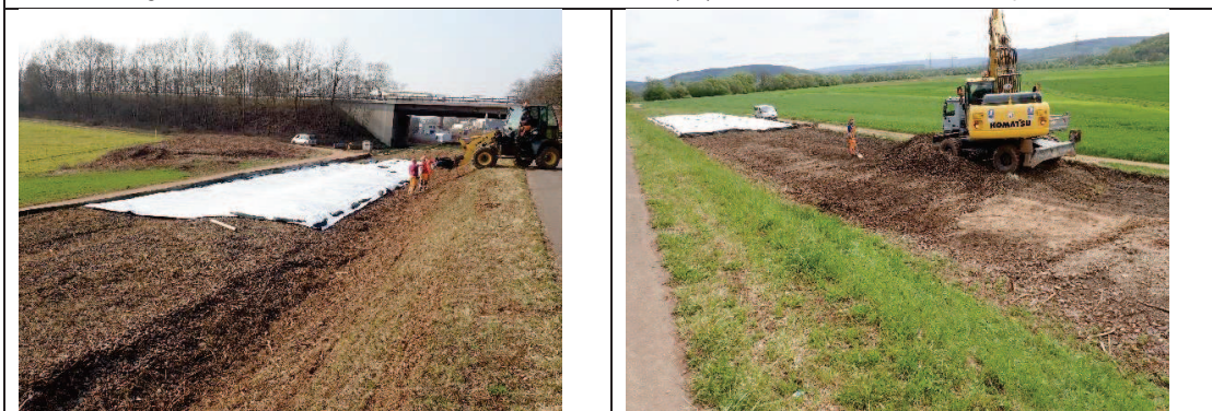
Südöstlich der Autobahn wurden die Mauereidechsen mit einer Folie schrittweise in den Bereich der Ersatzmaßnahme A4 vergrämt, der Schotter nachfolgend abgetragen und bei Maßnahme A3 eingebaut.
