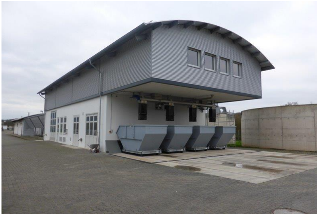
Abb. 14: neues Gebäude mit Annahmestation für Co-Substrate und Schlamm-entwässerung
