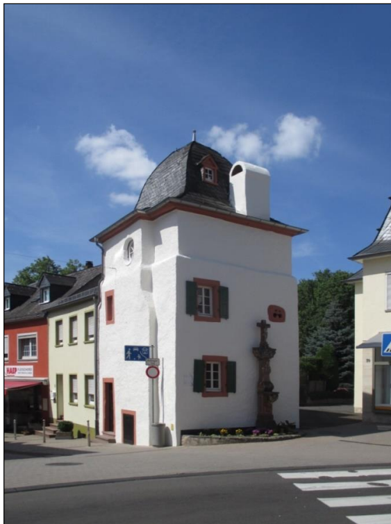
Abb.9: Türmchen nach den Sanierungsarbeiten
