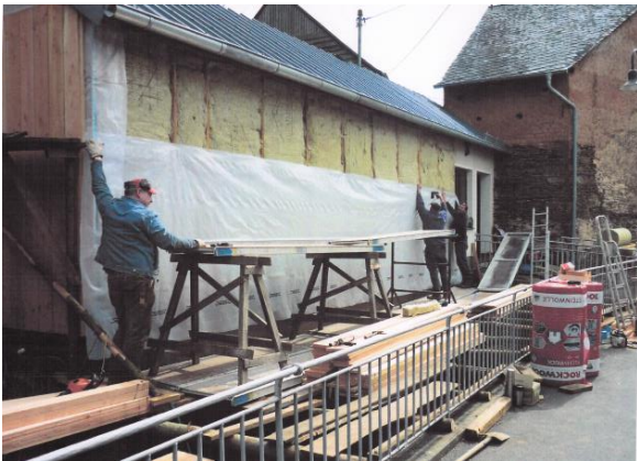
Abb. 11: Außenisolierung des Kühlhauses
