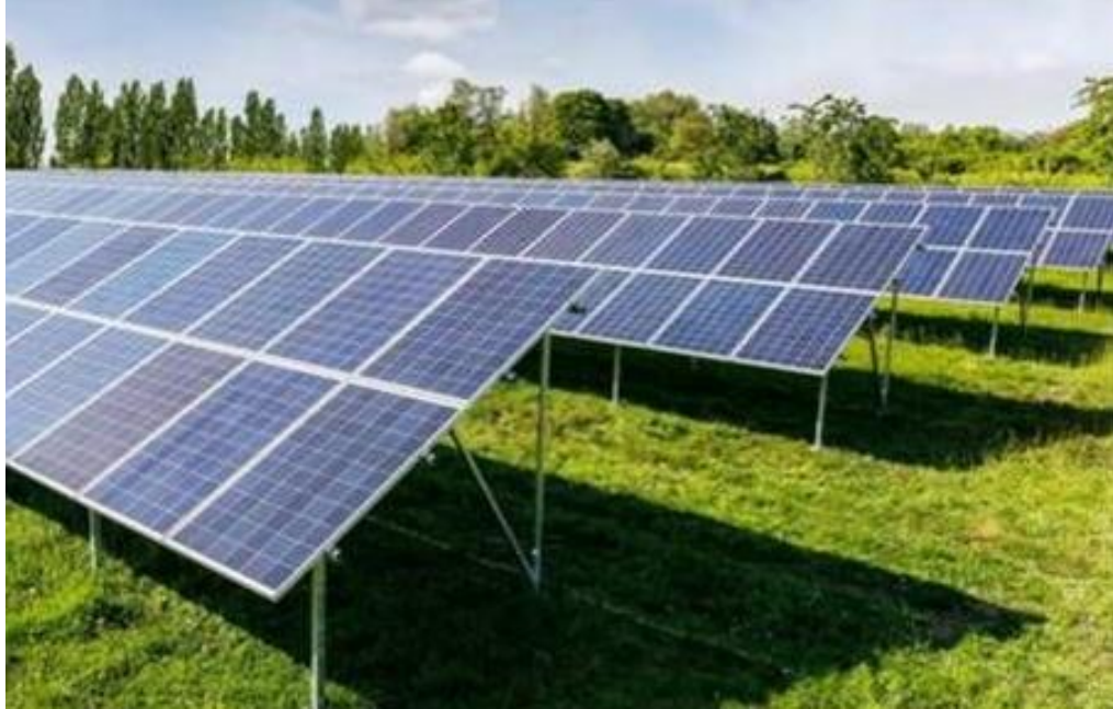
Abbildung 6: Beispiel der Montage der Solaranlage.
