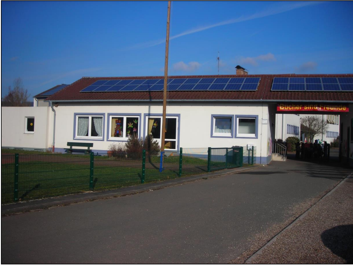
Abb.7: Solarmodule auf dem Dach der Grundschule Georg-Meistermann
