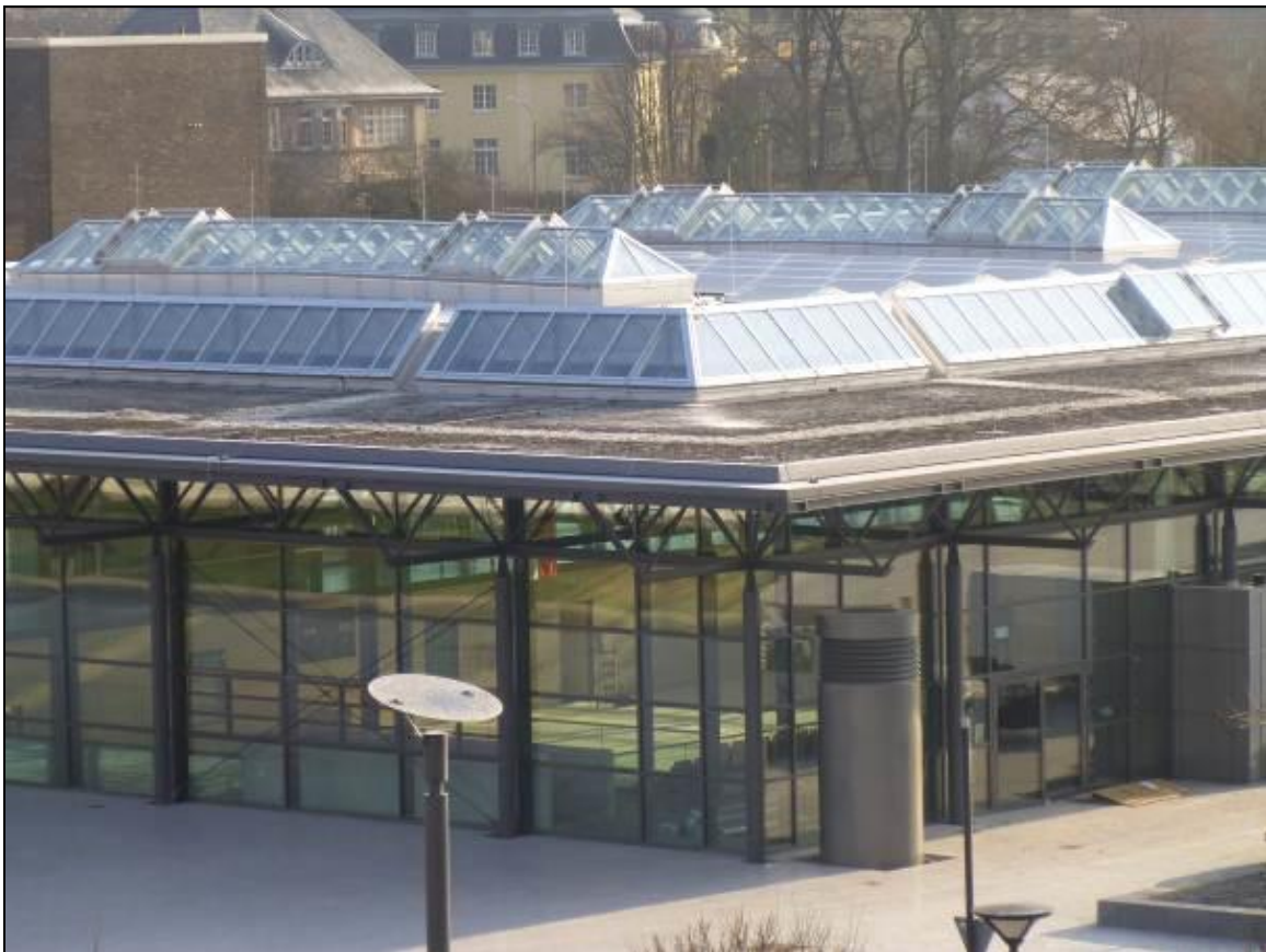
Abb.1.: Eventum Wittlich mit installierter PV-Anlage
