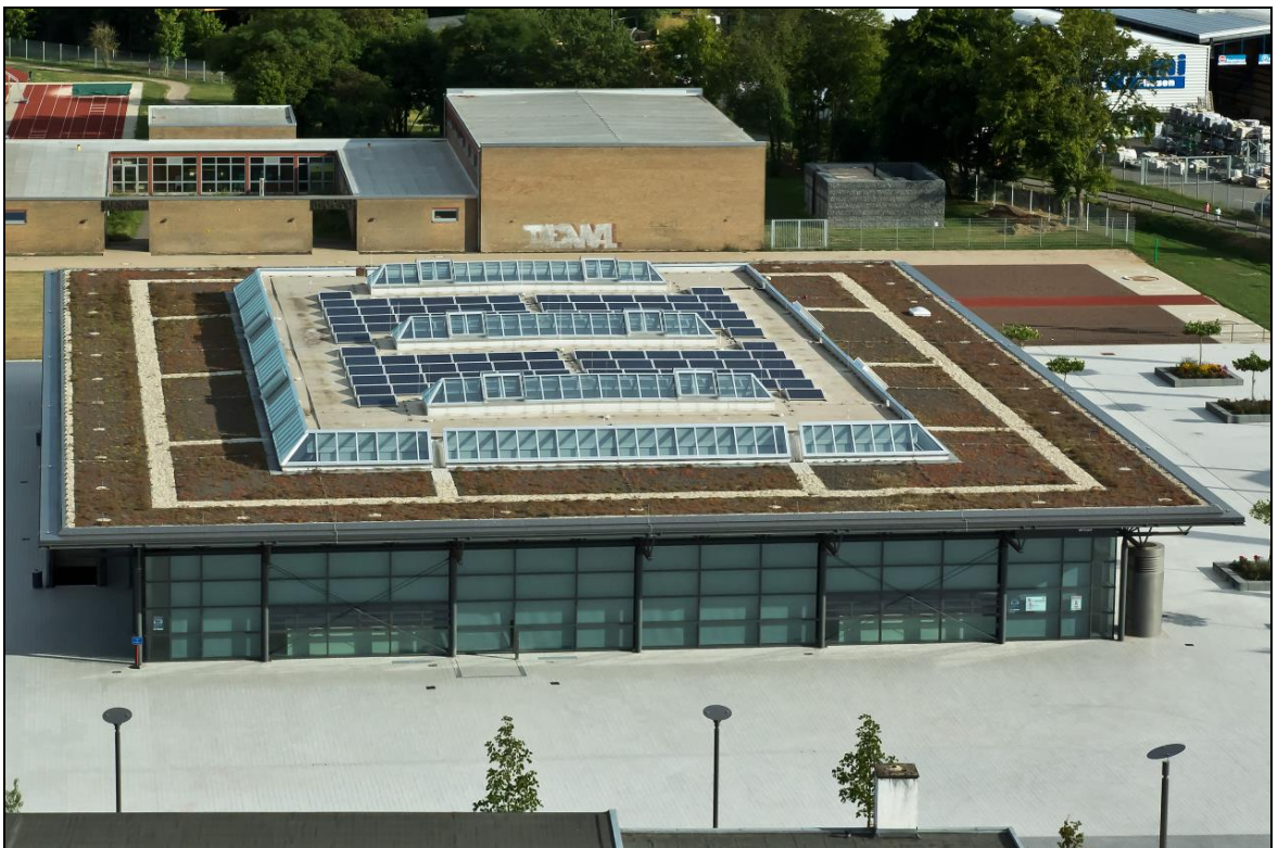
Abb.2.: Eventum Wittlich mit installierter PV-Anlage
