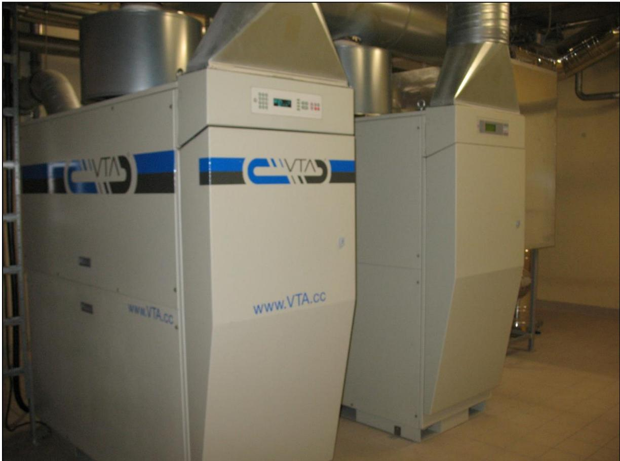
Abb.13: Neue Mikrogastrubine in der zentralen Kläranlage Wittlich
