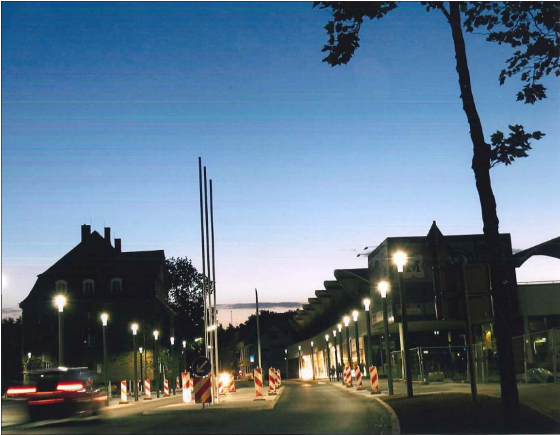
Abb.12: Neue Straßenlaternen mit LED-Technik im Bereich Kurfürstenplatz / Kurfürstenstraße
