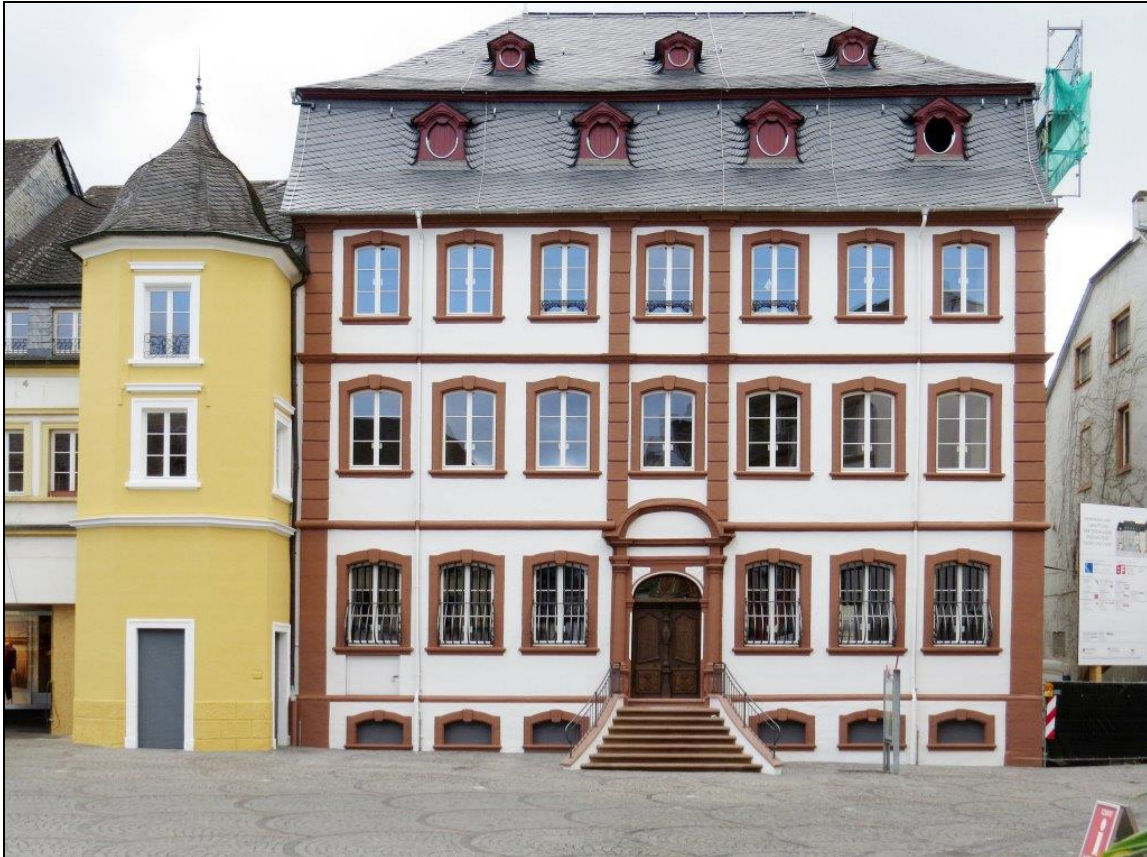
Abb. 10: Sanierte Fassade der alten Posthalterei
