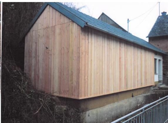
Abb. 12: Ansicht nach Abschluss der Arbeiten
