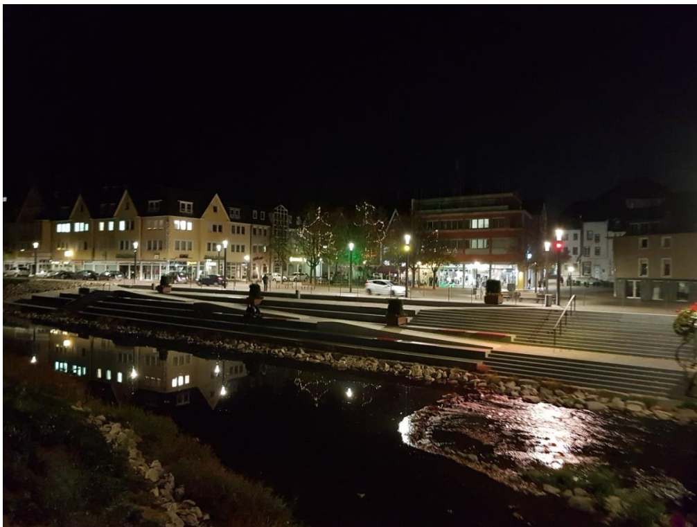
Abb. 19: Neue LED-Beleuchtung an den Lieserterrassen
