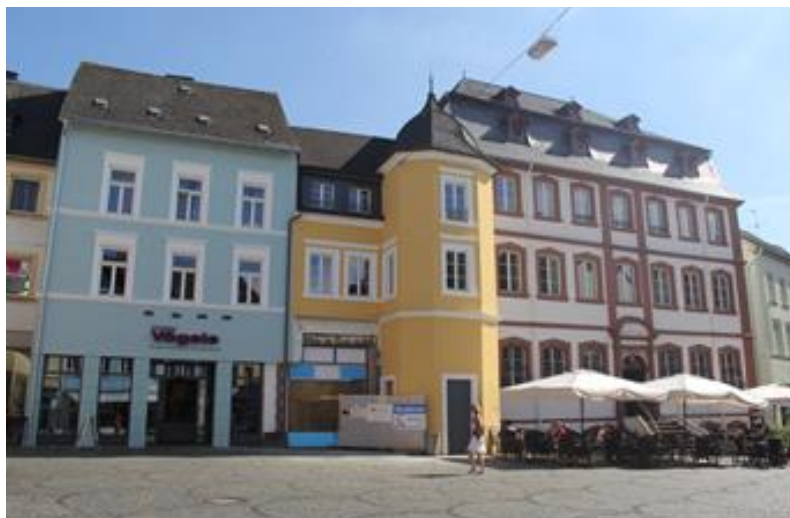
Abb.4: Sanierung der alten Posthalterei und den Nebengebäuden
