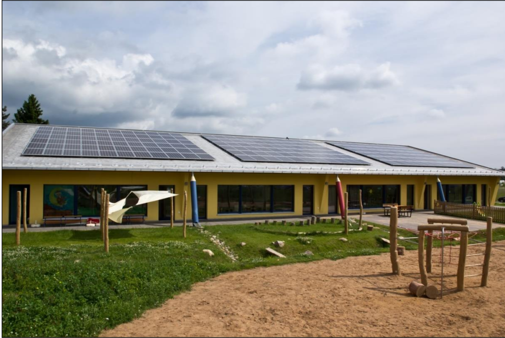
Abb.17: Kita Vitelliuspark mit installierter PV-Anlage
