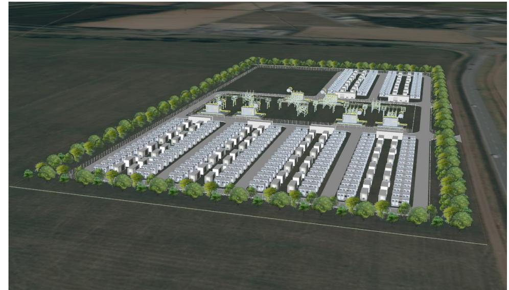
Projektv mit 300 MW / 600 MWh mit 6 Systemen vom Typ ES-50C
