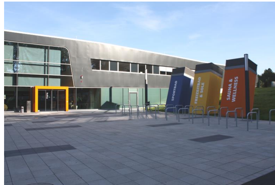
Be- und Entlüftungstürme als Gestaltungselement (Beispiel Hagen)
