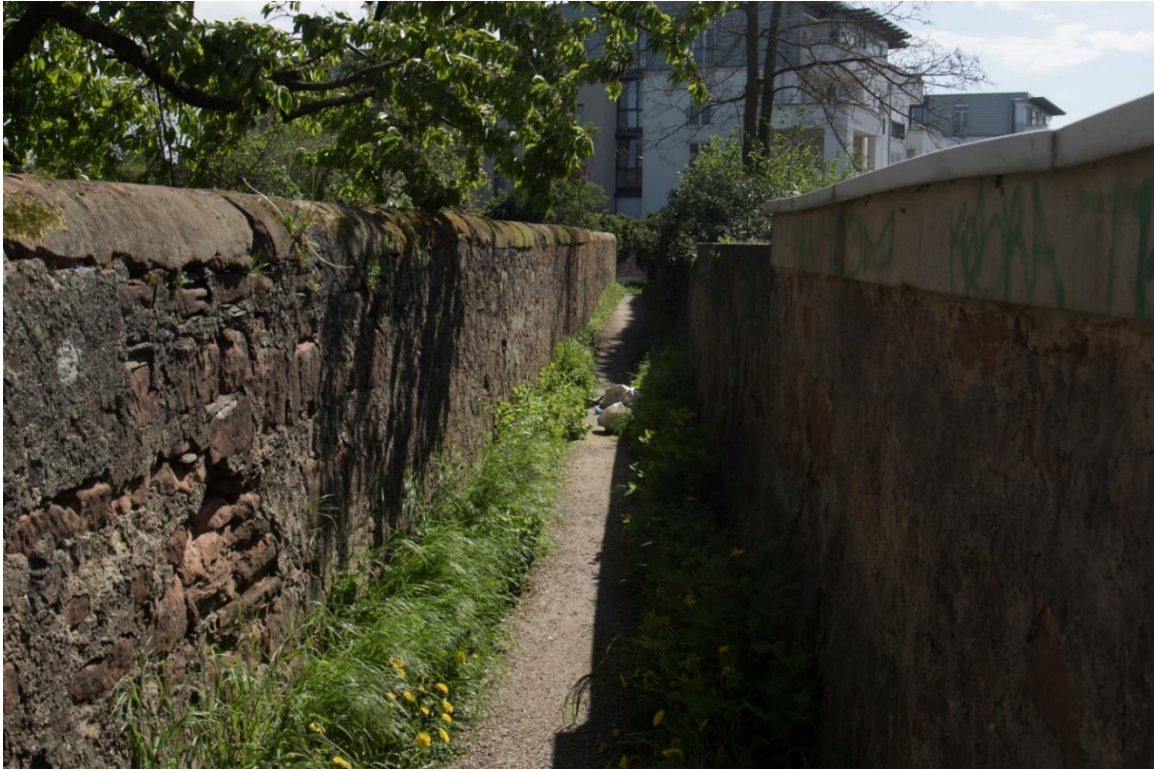
Foto 7: Bruchsteinmauer entlang der Parfümgasse (24.04.2019).
