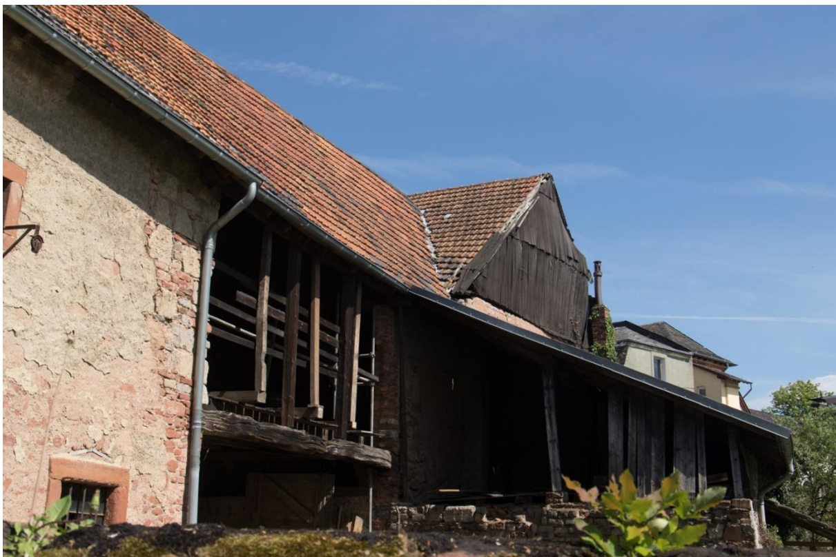
Foto 2: Südseite der Scheune (24.04.2019).
