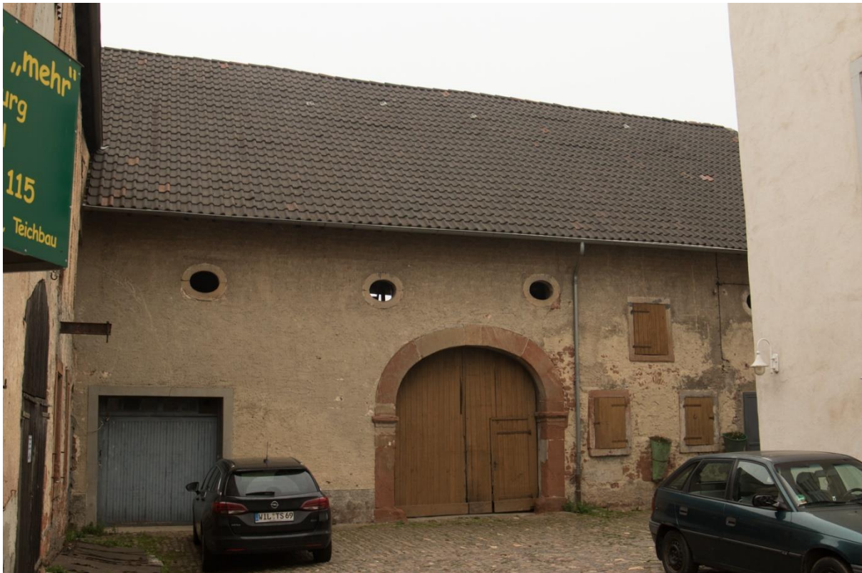
Foto 1: Nordseite der Scheune (08.04.2019).
