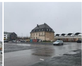
Blick von Norden
