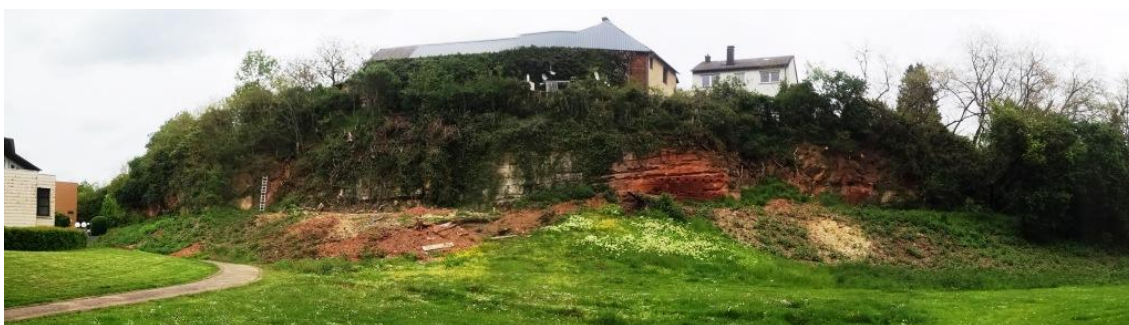
Übersichtsfoto der zu untersuchenden Felswand
