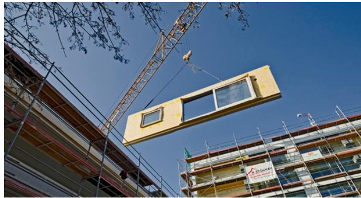
2 Anlieferung und Baustelleneinrichtung
