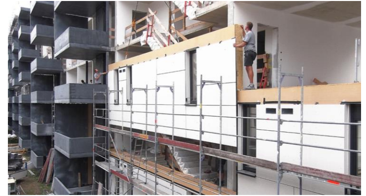
3 Modulmontage vor Ort
