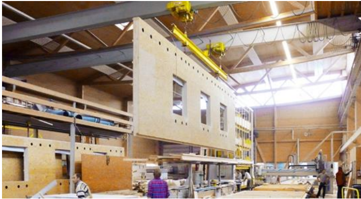
1 Vorfertigung im Werk (Parallel: Rückbau der bestehenden Fassade)
